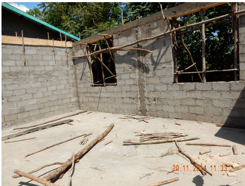
Practicumllokalen Dhanka in aanbouw
