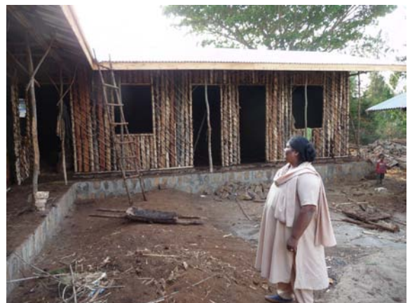
Zr. Lourdes bekijkt de bouw van de onderwijzerswoningen
