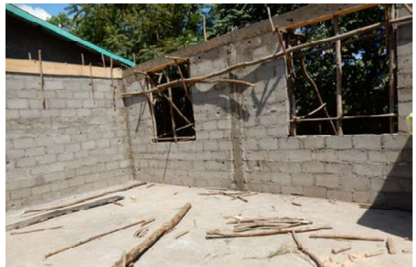
Practicumlokalen in aanbouw (Dkanka)
